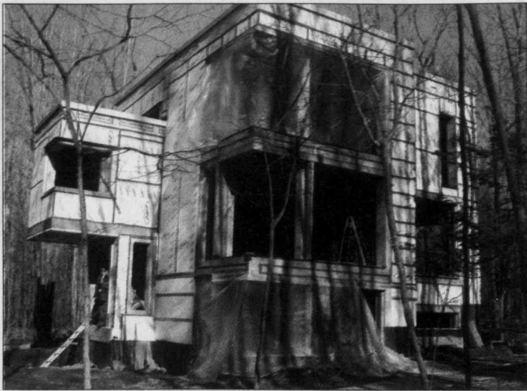
La maison en cours de construction d'Isabelle Grégoire et Sébastien Landry, à Sutton.
