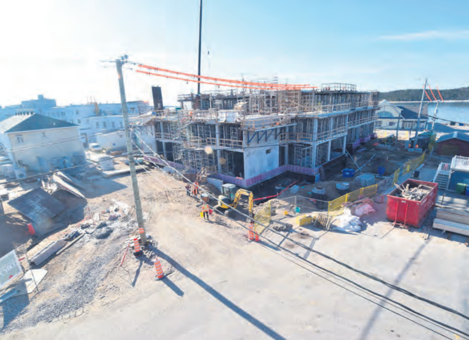
Les travaux progressent bien pour la maison des aînés de Havre-Saint-Pierre. Photo CISSS de la Côte-Nord
