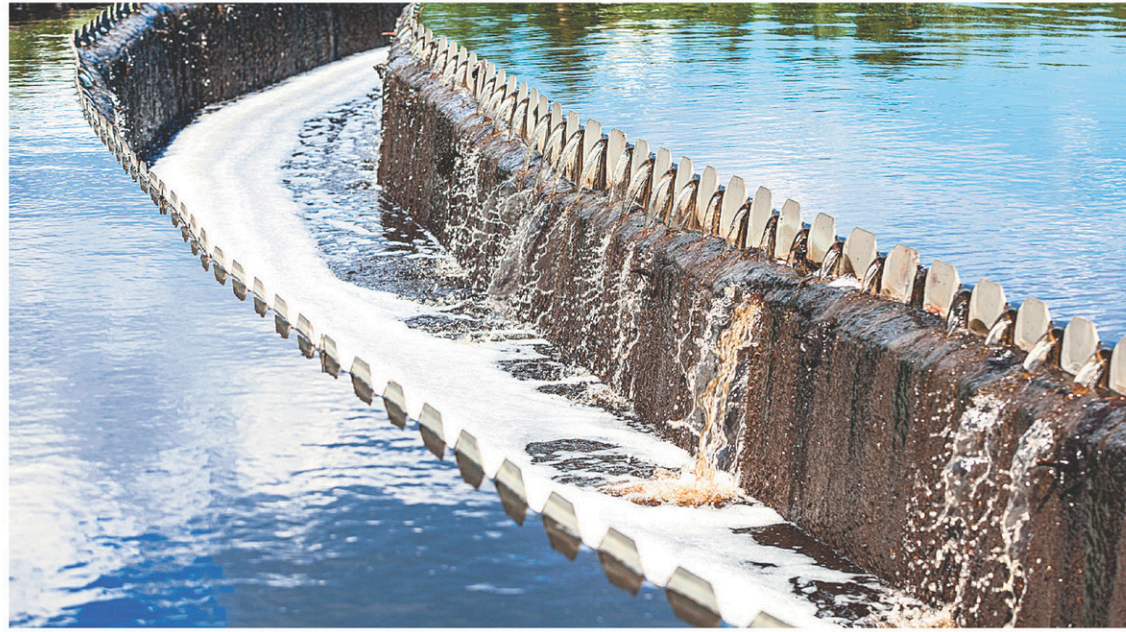
La Ville de Montréal prévoit la mise en service d'une unité d'ozonation dont l'objectif consiste à désinfecter, six mois par année, les eaux usées rejetées par l'agglomération dans le fleuve Saint-Laurent.
