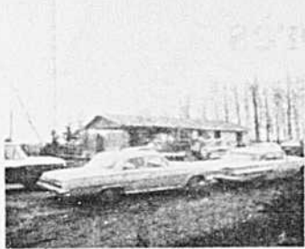
La maison à demi-construite photographiée le 7 avril
