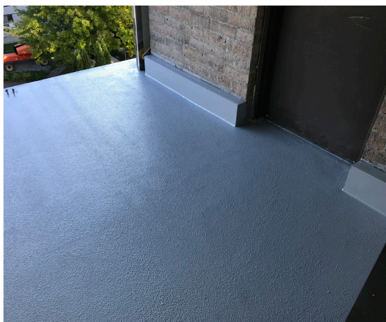
Nouvelles membranes des balcons
