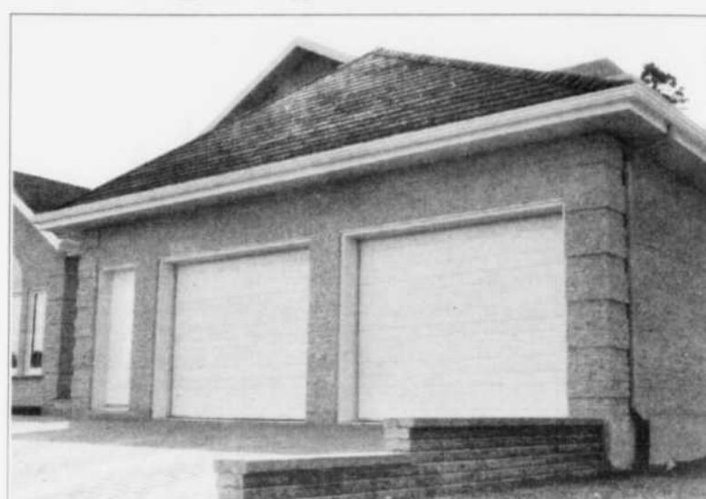
PORTE - Votre porte de garage est la plus grande pièce mobile de votre maison et il est important de voir à la rendre sécuritaire.
