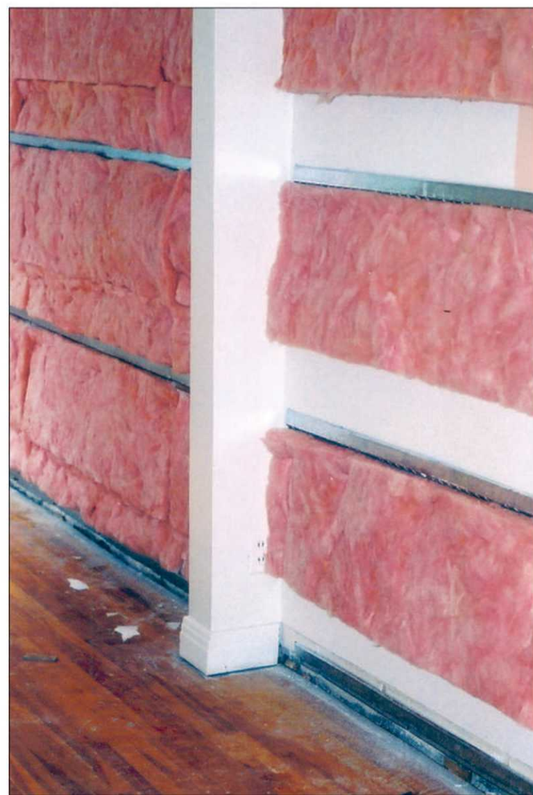
Un mur de fibres de verre en matelas bien installé empêchera que le son voyage derrière la nouvelle cloison. — PHOTO GUIDES PERRIER
