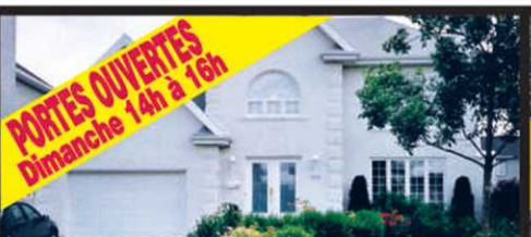
PORTES OUVERTES LE MESNIL, 7650, DE LA FRAÎCHEUR , magnifique 4 cc (2 étage + 2 s.-sol), 3 sb, climatisé, foyer, verrière 3 saisons, syst. al., asp. central, garage, pisc. creusée ch. 374 500$
