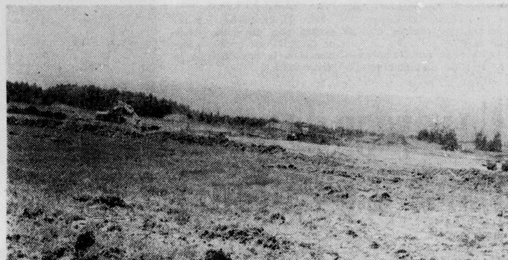
Les travaux ont débuté sur le chantier de construction de la future école polyvalente de Lac-Mégantic. Ces travaux sont effectués par la firme Pisia Construction. (Photo La Tribune, Gilles Dallaire)
