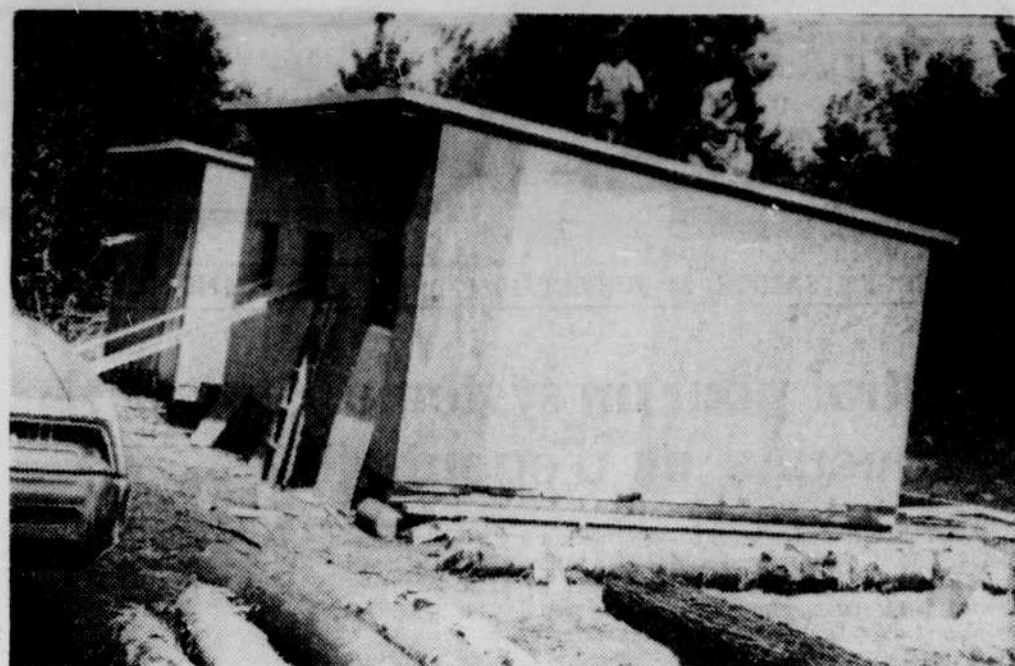
Les travailleurs s'affairent à construire des bâtiments qui leur serviront d'abri dans les forêts de Hampden. La société REXFOR, en collaboration avec le ministère des Affaires sociales et le ministère de l'Éducation avait dispensé des cours en restauration forestière au cours de l'année académique 70-71. (Photo La Tribune, Gilles Dallaire)
