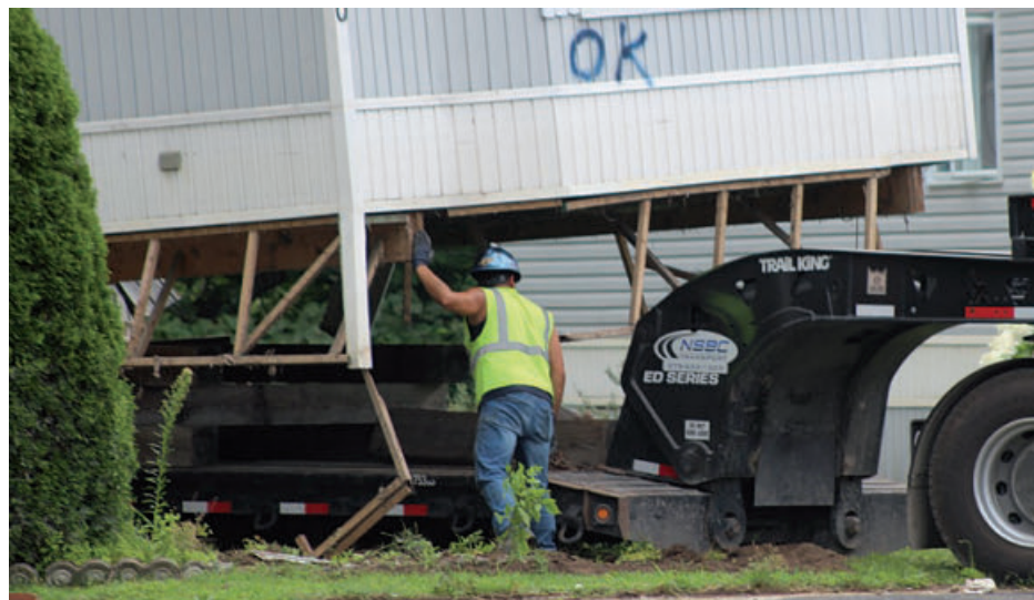
Photo Nicolas T. Parent Les travailleurs ont soulevé cette maison modulaire pour la déposer sur un transporteur.
