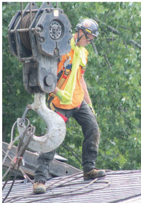
Photo Nicolas T. Parent Voici un crochet et des câbles servant à soulever le bâtiment de quelques dizaines de tonnes.
