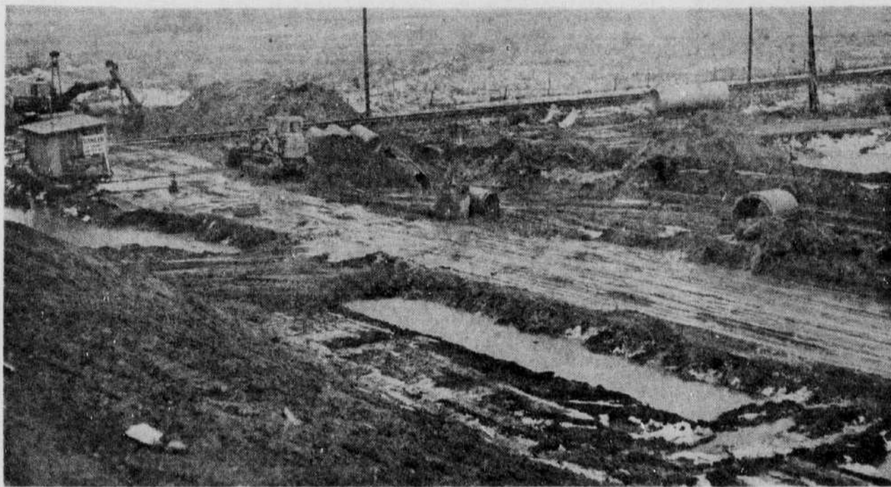
Travaux d'égouts, sur le boulevard Charest-Ouest, à Sainte-Foy.
