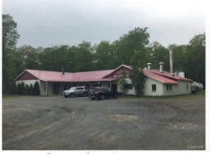
STE-THÈCLE, Érablière +/- 25 000 entaillés, quota +/- 100 000 lb, cabane à sucre, entrepôt, équipements complets, chalet et plus, 1 995 000$
