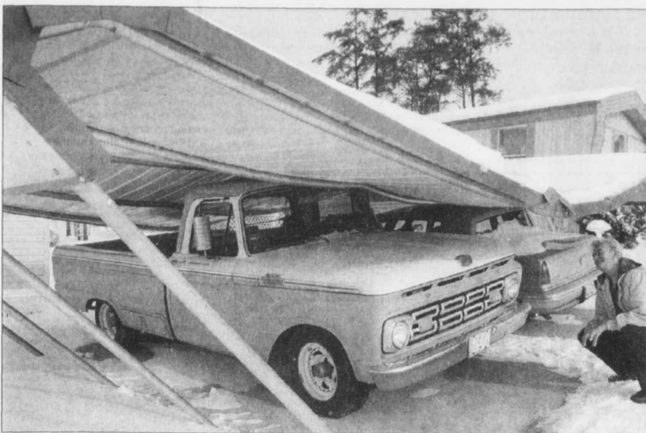
Lester Haring examine les dommages subis par sa camionnette et sa voiture après l'effondrement d'un abri d'auto tout neuf, sous le poids d'une masse de neige à Knoxville, dans l'État américain du Tennessee.
