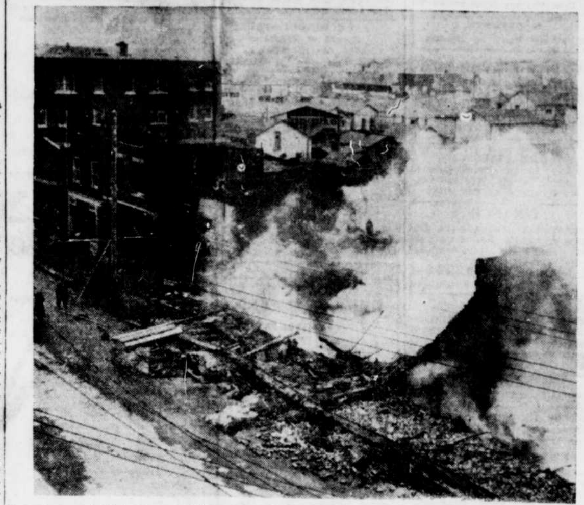
7 personnes ont été brûlées mortellement ou ont péri en se jetant par les fenêtres de l'hôtel Albert en feu, à Rouyn, Qué. Une conflagration a rasé tout un pâté de maisons dans le centre de cette petite ville minière prospère. Cette photo donne une vue générale de la région dévastée.
