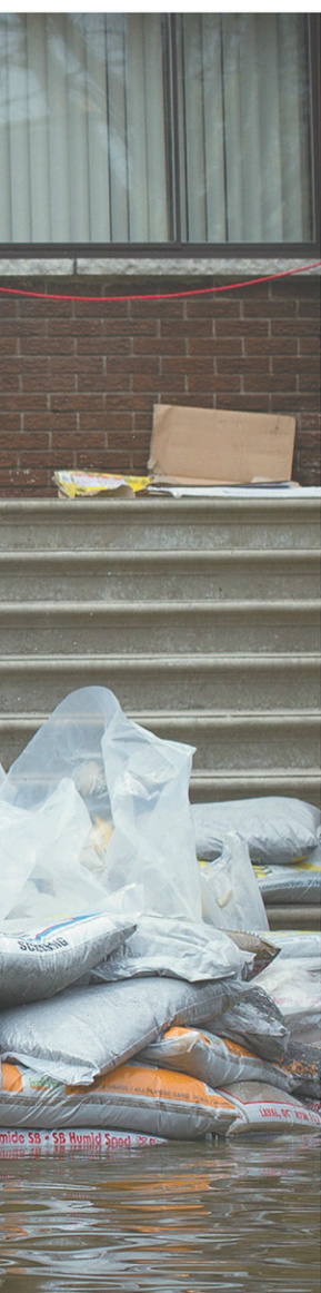
Inondations au printemps 2017 dans Ahuntsic-Cartierville, à Montréal. Les experts recommandent de construire les bâtiments en milieu inondable de façon plus résiliente.
