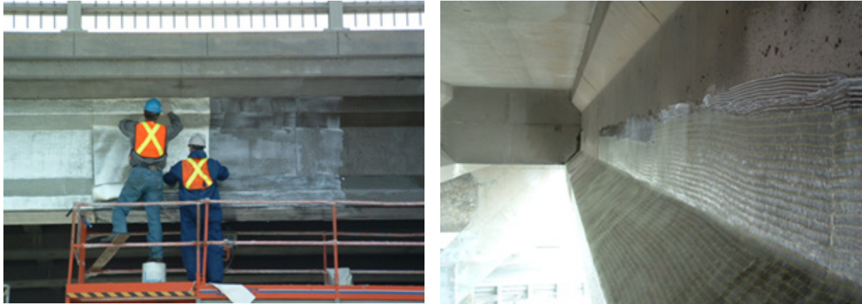
Photo 7.2-1 Chemisage sur des poutres en béton précontraint
