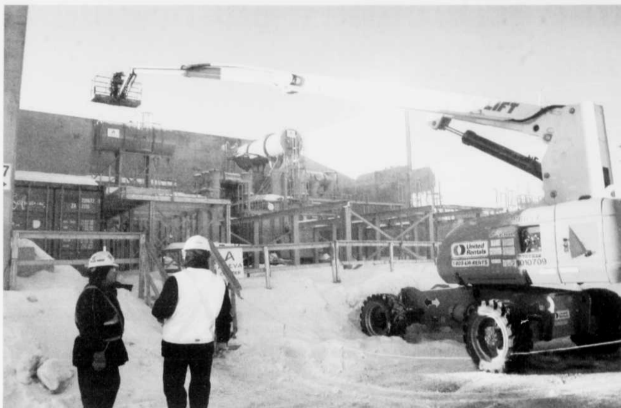
La sécurité est primordiale sur un chantier de construction. Il faut toujours évaluer les risques et l'environnement qui changent continuellement. Voici des travailleurs du chantier de l'Usine pilote AP50 Jonquière qui effectuent des travaux sur les transformateurs de la sous-station électrique.
