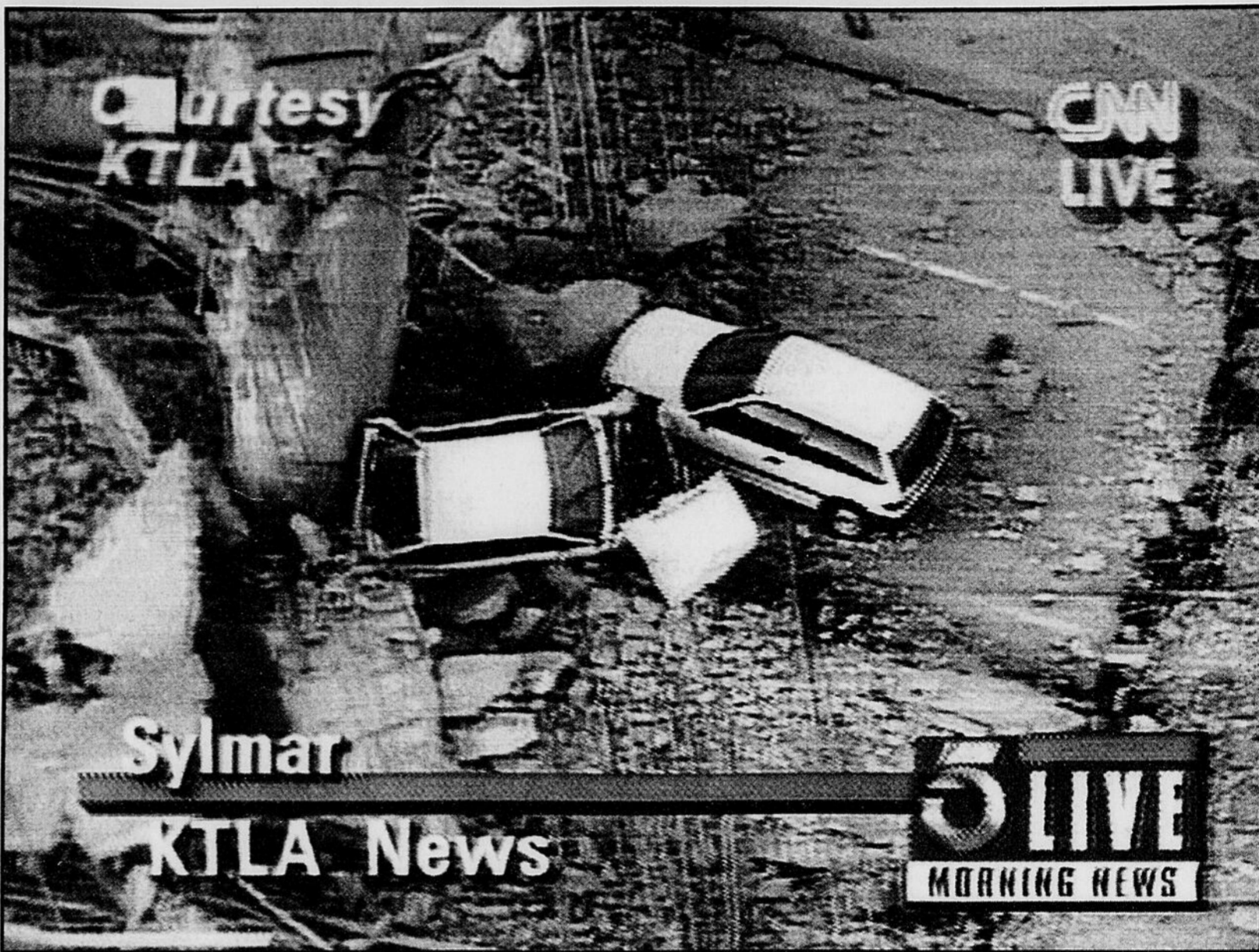
Une station de télévision de la Californie, affiliée à CNN, montre une image éloquent d'un tronçon surélevé d'autoroute qui s'est effondré dans la région de Sylmar. Des carcasses de voitures gisent emprisonnées dans les débris, mais si le séisme s'était produit dans la journée plutôt que la nuit, le tableau aurait été bien plus dramatique.
