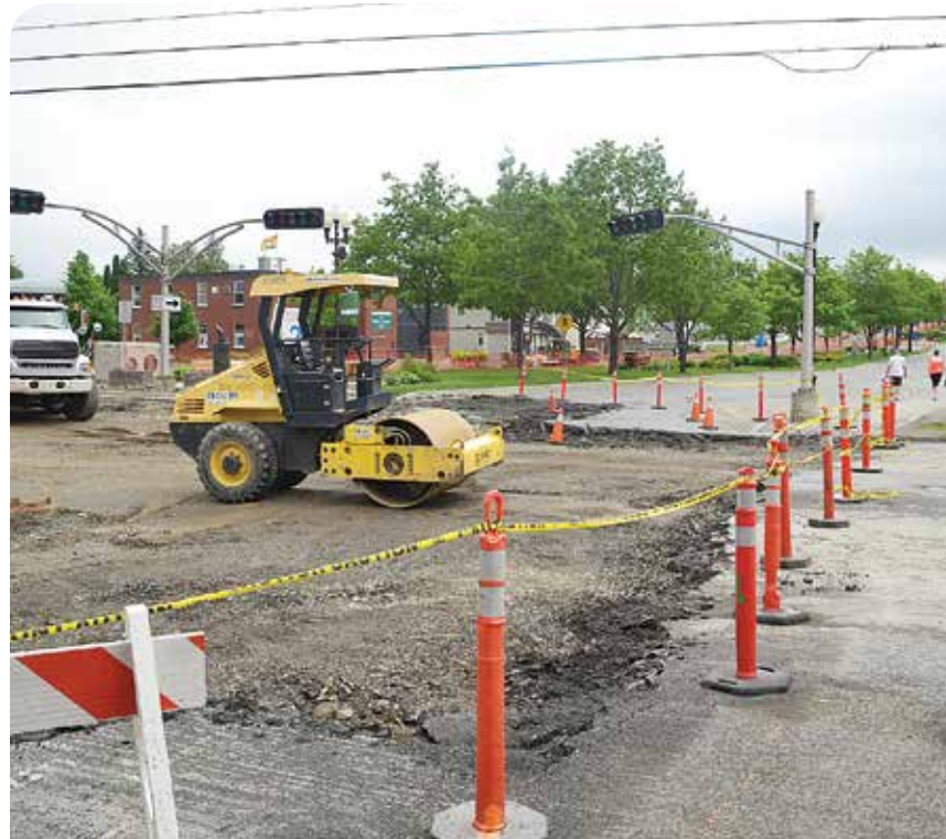
La deuxième phase du projet de réfection du boulevard Broadway ira de l'avant en 2021. Photo archive: Brunswick News
