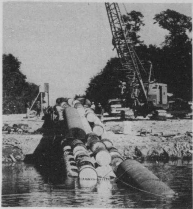
Les Cantons de l'Est, région en plein essor du Québec, seront bientôt approvisionnés en essence, huile de chauffage et autres produits pétroliers par le pipe-line Québec south Shore. On est à installer ici un tronçon qui part de la raffinerie de Montréal-Est de l'Imperial Oil et traverse le Saint-Laurent à destination de Boucherville, d'où le pipe-line se prolongera jusqu'à Drummondville. Les Cantons de l'Est étaient approvisionnés jusqu'ici par camion.
