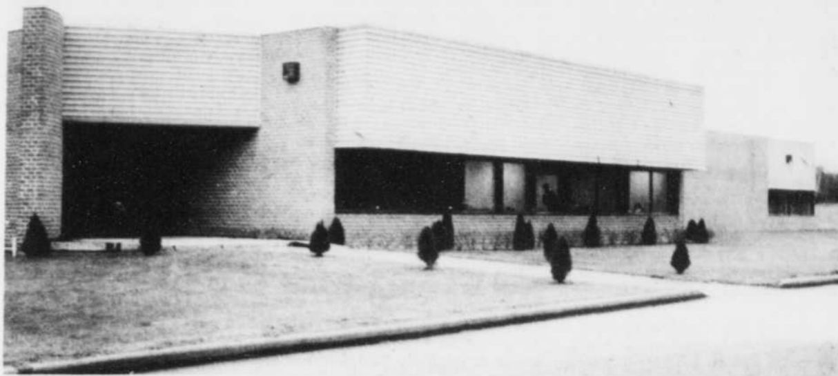
Les locaux de C-MAC, dans le parc industriel de Sherbrooke.
