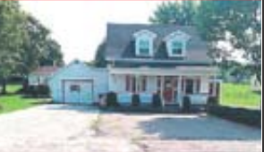
ST-NICOLAS • 1159, Chemin Vire-Crêpe, Coquet cottage 3 c.c. bcp de rénovations récentes pas de voisin arrière. Coin très agréable. FAITES VITE!!
