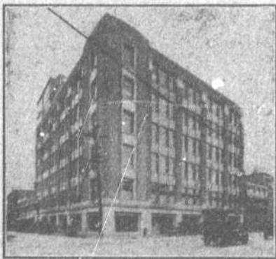
Le nouvel édifice Dupuis Frères, érigé par Archambault & Leclair. Ingénieur: Arth. Surveyer; Architecte: H. S. Labelle.
