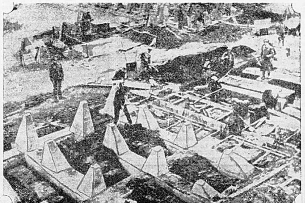
Une des rares photographies des fortifications allemandes qui font face à la frontière française. Ces pointes de béton ainsi disposées forment une ceinture défensive contre les attaques des chars d'assaut devant les forts souterrains de la ligne Siegfried, réplique allemande de la ligne Maginot française. Les Allemands croient que ce procédé est le plus efficace de tous.
