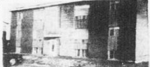
6 LOGEMENTS situés au no 568 Boul. Baril à Princeville, construction en brique, chauffage à l'eau chaude.
