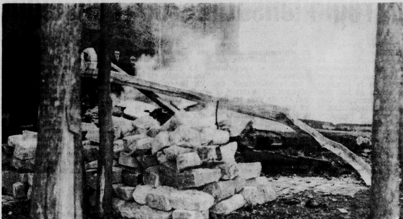
De la résidence de M. Antonio Bouffard, il ne reste debout que le foyer de pierre. On estime à $25,000 les pertes de cet incendie, qui a obligé les occupants de la maison à quitter leur demeure en toute hâte. (Photo La Tribune, par Gilles Dallaire)
