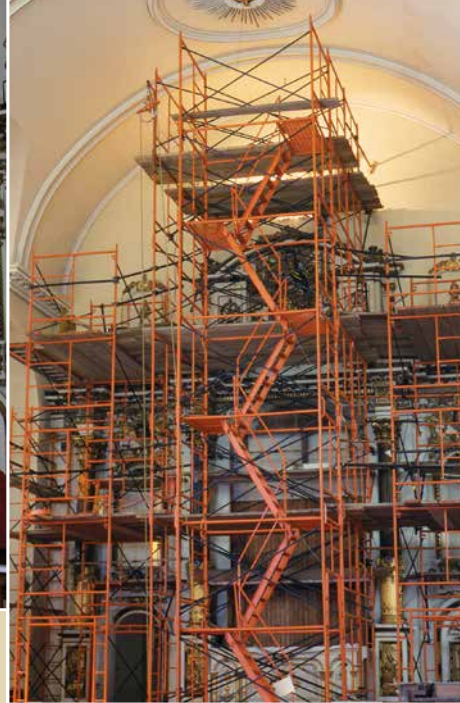
■ L'échafaudage installé devant le retable principal. Photo: Michel Élie, CCQ
