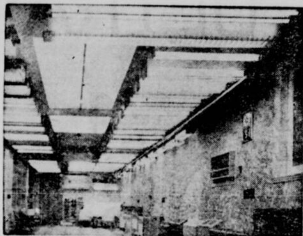
Salle d'échantillons. Choix de 400 modèles de fixtures fluorescentes
