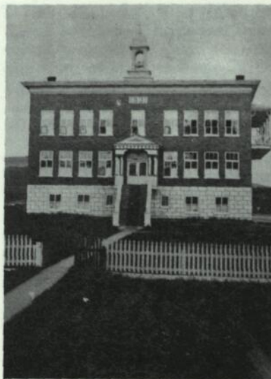
Ancien couvent, construit en 1931.
