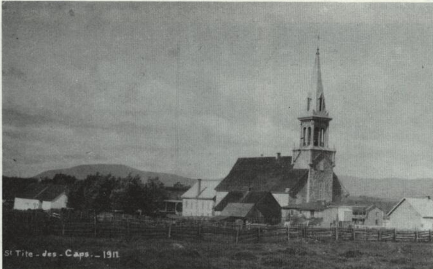
Au premier plan, on remarque la très ancienne salle paroissiale, construite vers 1871; à gauche l'ancienne grange du curé.
