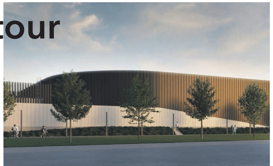
Le projet du nouvel aréna pour Sept-Îles a été revu plus d'une fois. L'écran architectural (sur le toit à gauche) n'en fait plus partie. De mars 2023 à juillet, 14 M$ ont été coupés. Image Lemay - Architecture et Design
