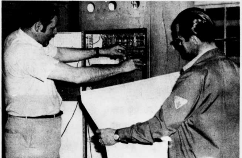
LE TABLEAU DE CONTROLE ELECTRONIQUE a demandé des mois et des mois de planification, de recherche et de travail. C'est une réalisation qui fait la joie et la fierté de Donald Fillion à gauche, électricien à l'Alcan à Arvida et de ses coéquipiers. Il a fallu consacrer bien des soirées pour réaliser le plan détaillé qu'a conçu M. Fillion.
