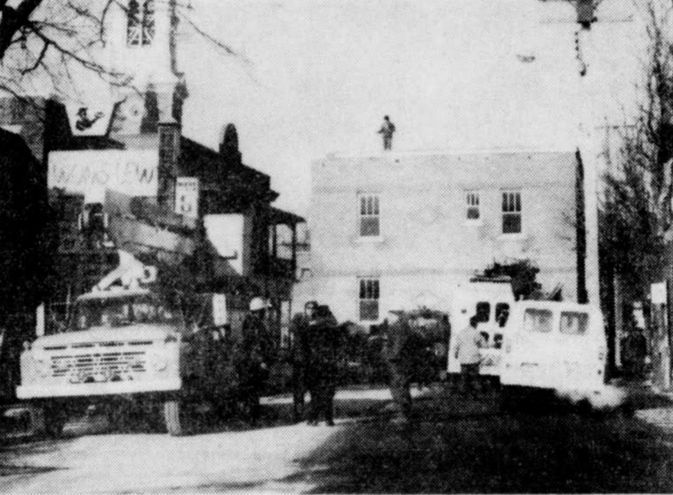
ON DEMENAGE! — La circulation a été quelque peu ralentie sur la rue Notre-Dame ouest, hier matin, alors que l'on a transporté une maison de 4 logements avec précautions, depuis la rue du Presbytère jusqu'à la rue Larivière, via le boulevard Jutras. (Photo La Tribune, Victoriaville)
