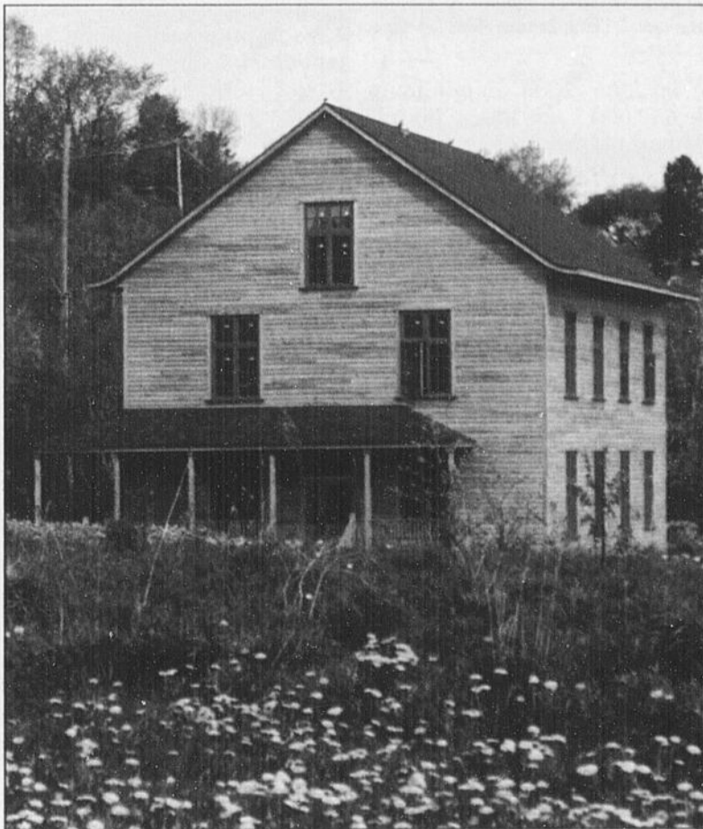
MAISON DE L'ÉCOLOGIE - L'ancien moulin à farine Riverin connaît une phase de restauration importante et sera transformé en Maison de l'écologie et de l'environnement. L'ouverture officielle est prévue pour le 19 juillet 2006.
