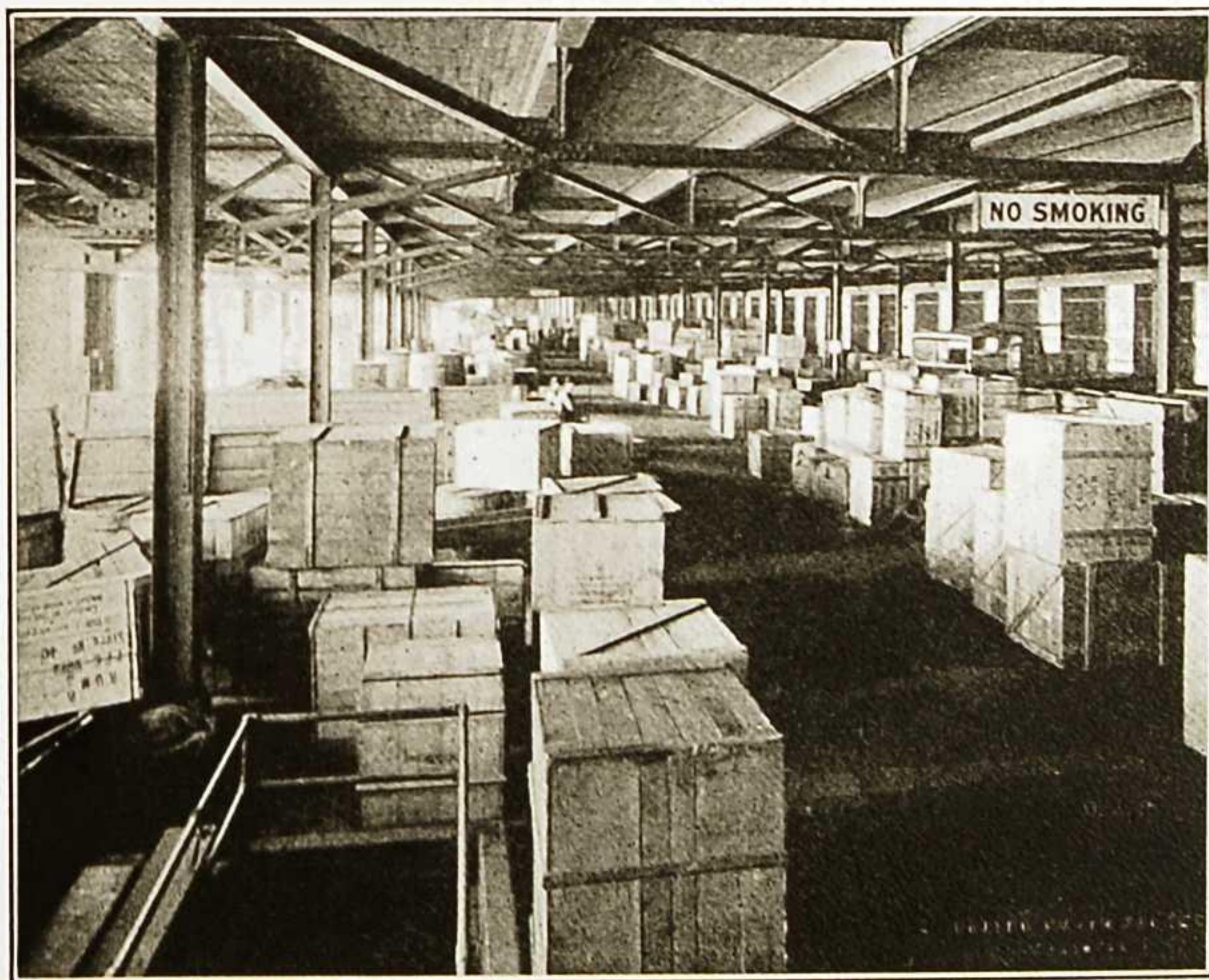
Intérieur d'un hangar de fret
