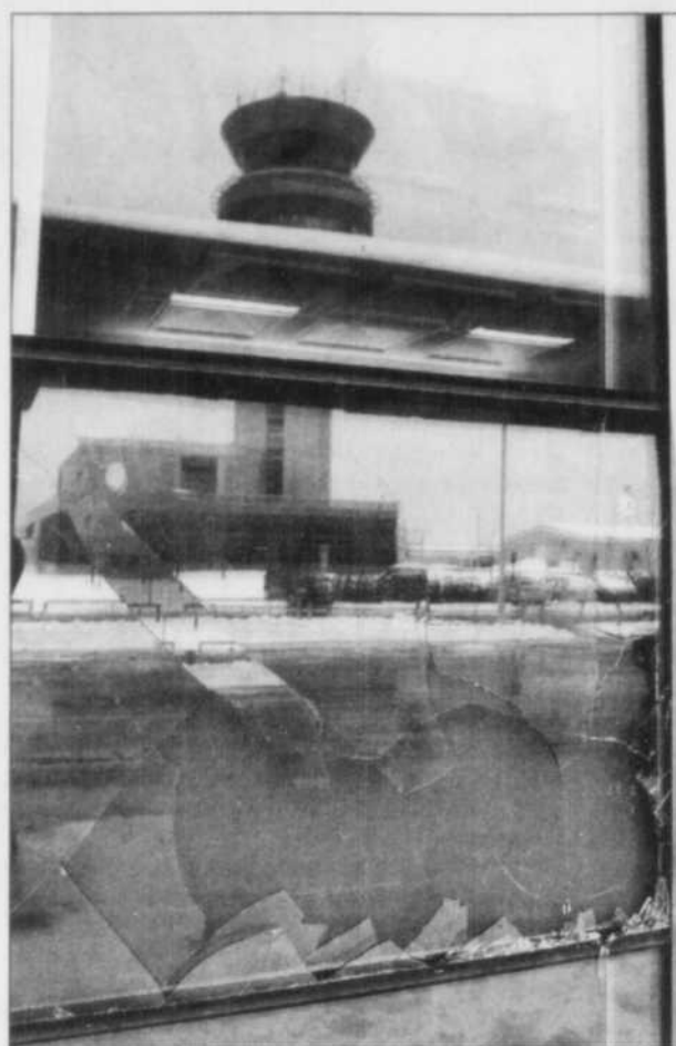
Quelques fenêtres ont été fracassées.
