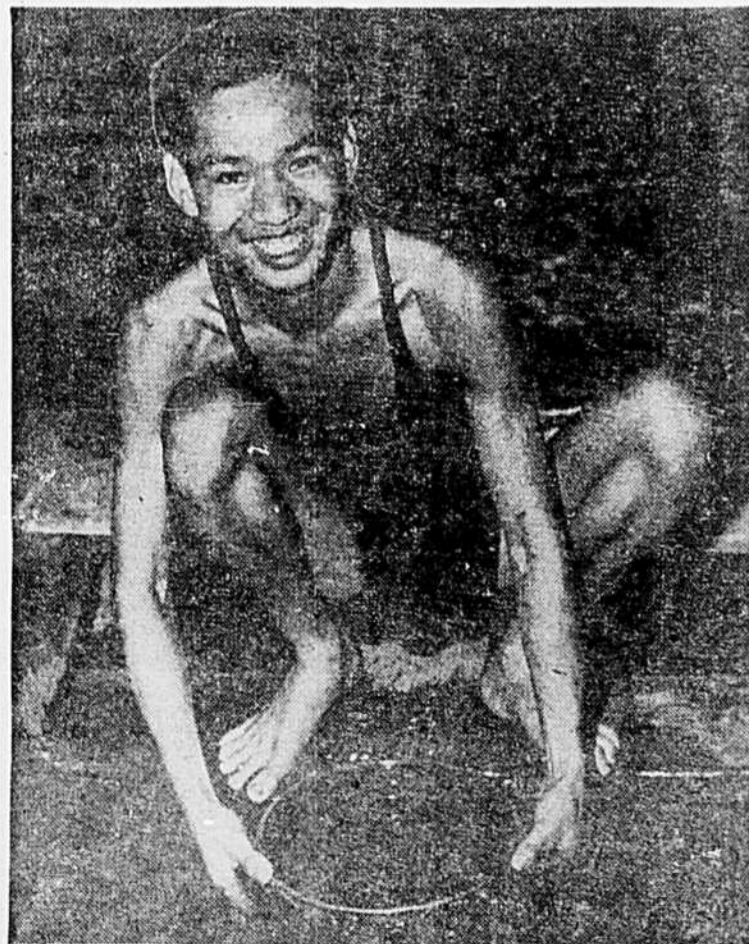
Dans une mine des environs de Kotatinggi, un ouvrier chinois, Seow-Chong-Kui traite au moyen d'un tamis des pyrites contenant de l'étain. (Ces pyrites contiennent du sulfure d'étain, du cuivre et du fer.) C'est la dernière opération du traitement du minéral avant le commencement du raffinage qui comprend divers traitements physiques et chimiques.
