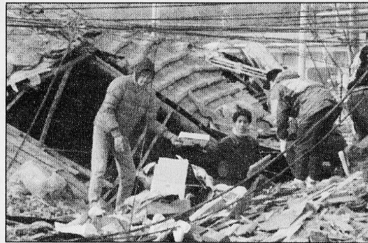
VICTIMES - Des victimes fouillent les ruines de leur demeure à Kobé dans l'espoir de récolter quelques objets. Il y a des milliers de personnes qui sont sans abris dans cette ville depuis le séisme.
