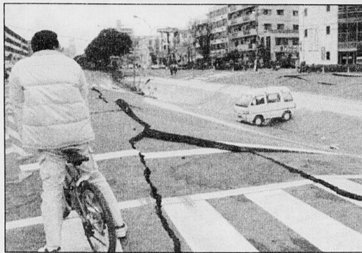
RUE - Un cycliste regarde une rue qui a été particulièrement endommagée lors du séisme qui a frappé le Japon cette semaine. Tout le pavé s'est enfoncé.
