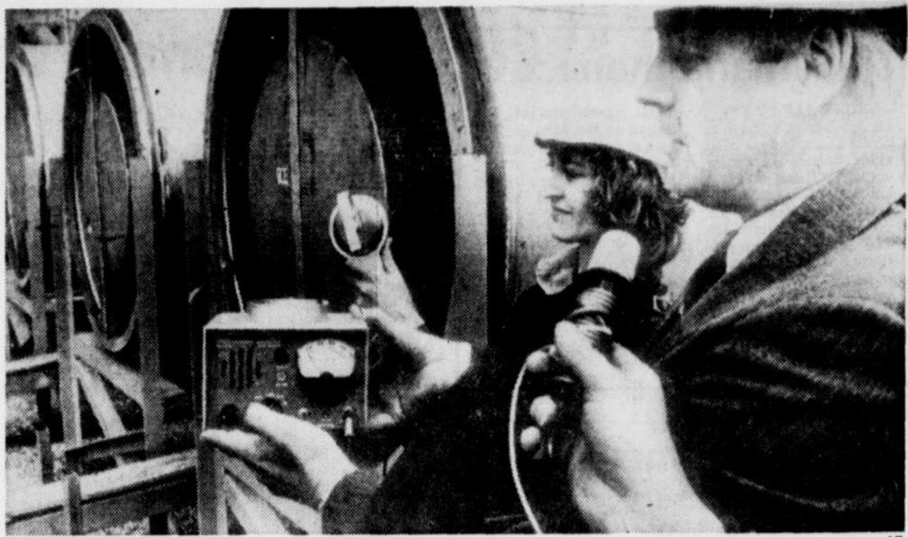
Les dirigeants et experts de la centrale de Three Mile Island procède à la décontamination du bâtiment qui abrite le fameux réacteur endommagé l'année dernière.
