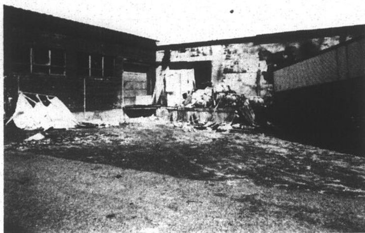
L'entrepreneur a filé en douce en laissant des rebuts derrière lui. (Photos Jacques PAUL)
