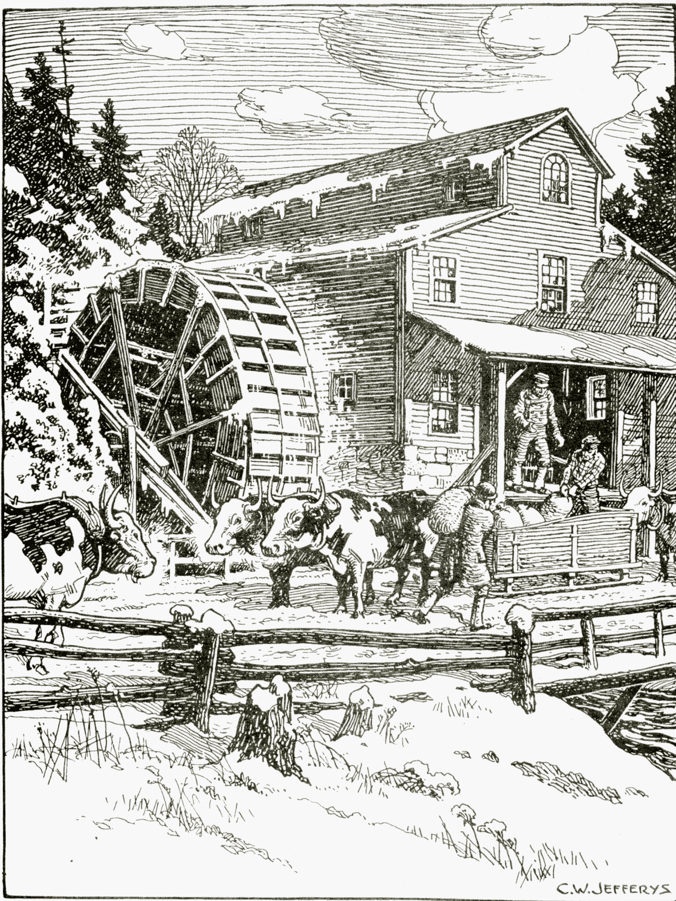
Un moulin à blé hydraulique
