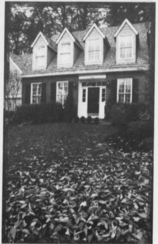
Des fenêtres mal ajustées ou fendillées laissent passer les courants d'air ou peuvent produire de la condensation trop rapidement, signe qu'elles ne sont plus efficaces. (Phot : EN)
