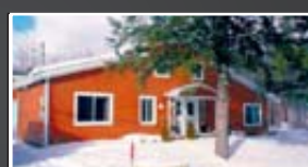
GRAND GARAGE 269 000$ SAINT-HIPPOLYTE 3 chambres beaucoup de rénovation très chaudière MLS 21913492
