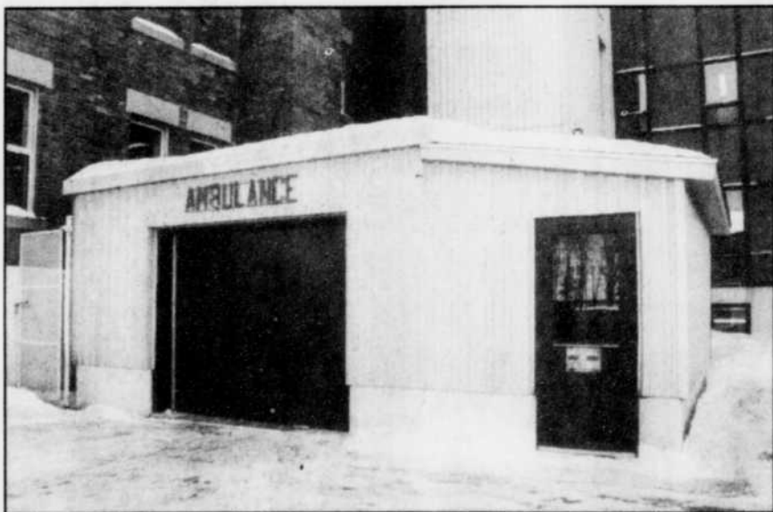
(Photo Marcel Aubry) Le garage réservé à l'arrivée des ambulances à l'Hôpital du Christ-Roi de Nicolet fera l'objet d'un agrandissement à même l'enveloppe budgétaire de 8,6 millions $ destinée aux travaux de transformation de l'établissement.
