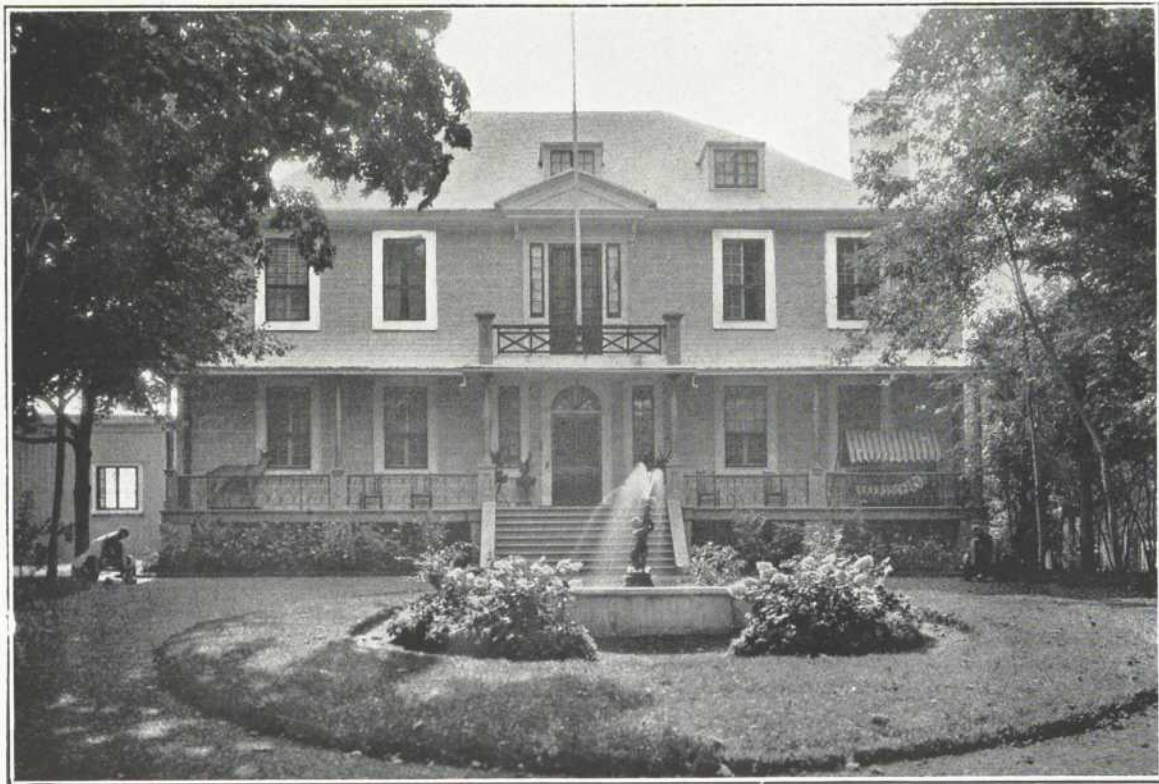
LE MANOIR COUILLARD À MONTMAGNY
