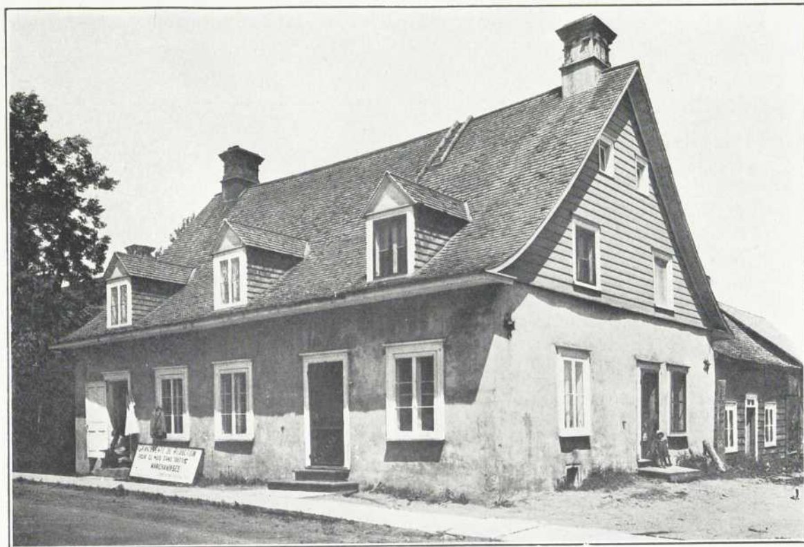
LA MAISON GOUIN-BUREAU À SAINTE-ANNE-DE-LA-PÉRADE
