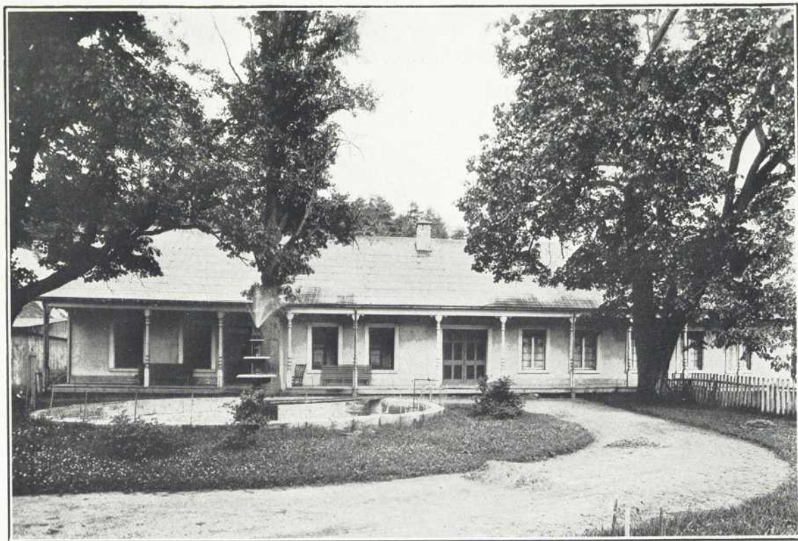
LE MANOIR DES LE GARDEUR DE REPENTIGNY À SAINT-HENRI-DE-MASCOUCHE
