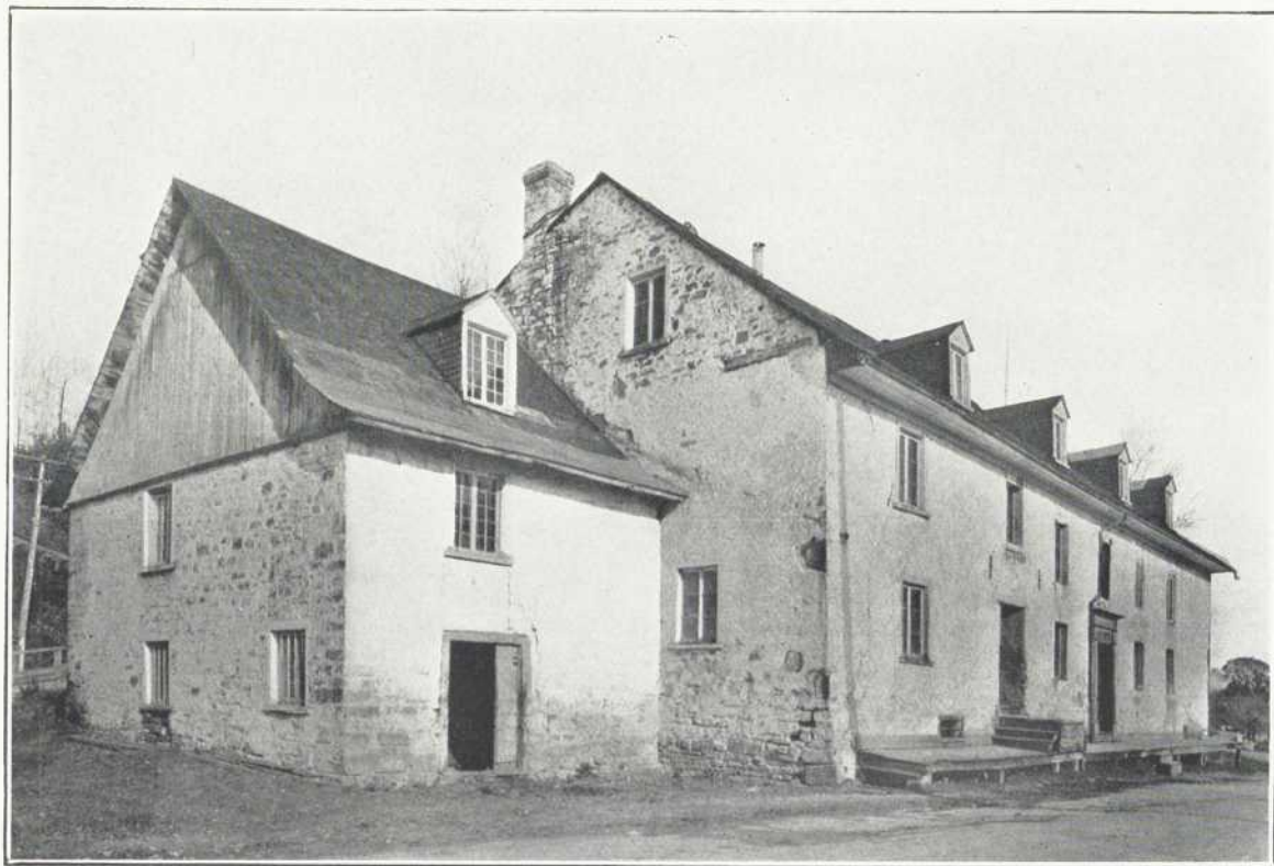
LE MOULIN DU PETIT-PRÉ AU CHÂTEAU-RICHER
