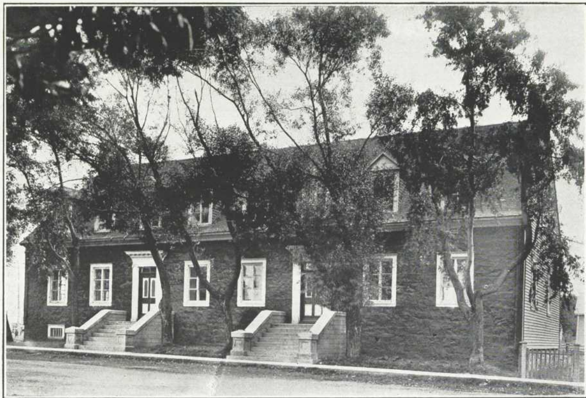
L'ANCIEN PRESBYTÈRE DU CAP-SAINT-IGNACE
