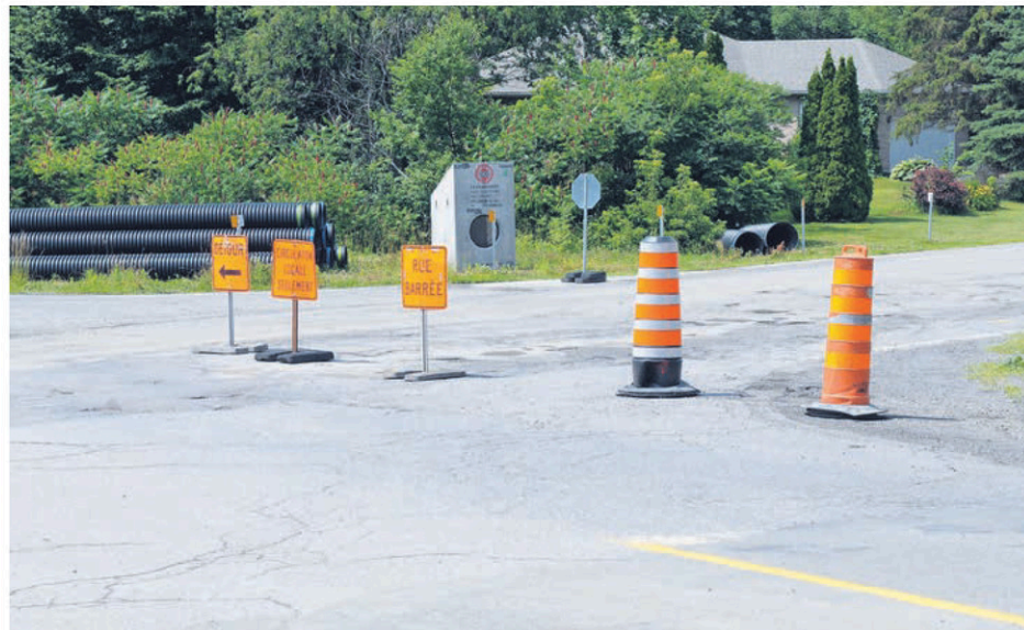
Parmi les projets en importance qui sont en cours, notons la réfection de la rue Saint-Hubert, qui vise notamment à refaire les fondations, le pavage et à mettre en place une piste multifonctionnelle. (Photos: Granby Express-Vincent Lambert)
