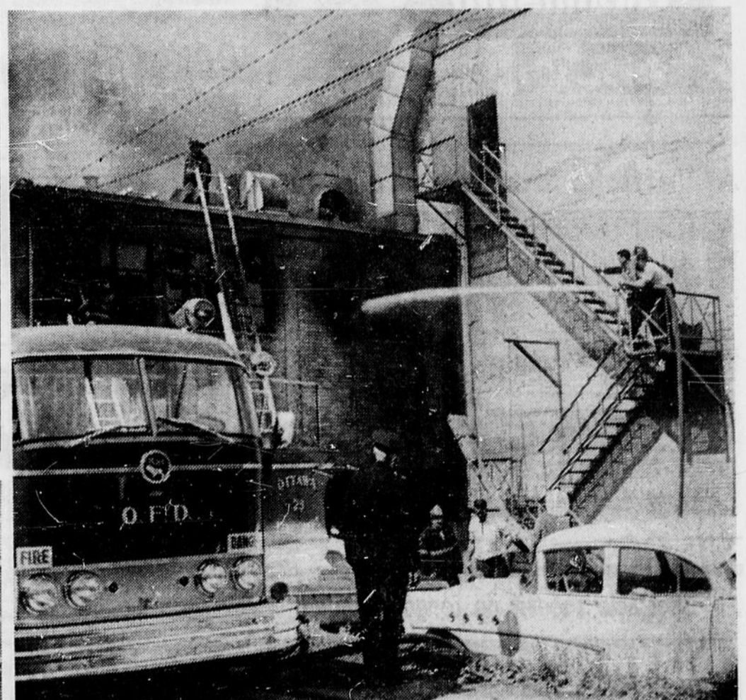
Un des pires foyers de l'incendie était la partie arrière de l'hôtel, que l'on voit ci-dessus, et qui abritait le système de ventilation. C'est
