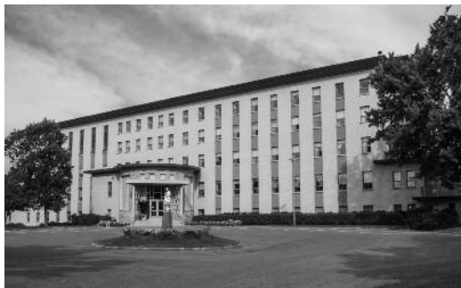
Maison généralice des Sœurs du Bon-Pasteur de Québec
