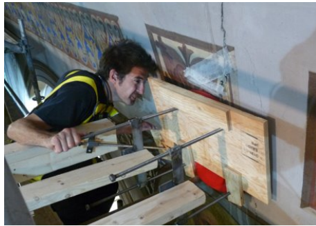
Figure 57 Consolidation des couches d'enduit ©CCQ/MCC, Elizabeth Cloutier 2016.
