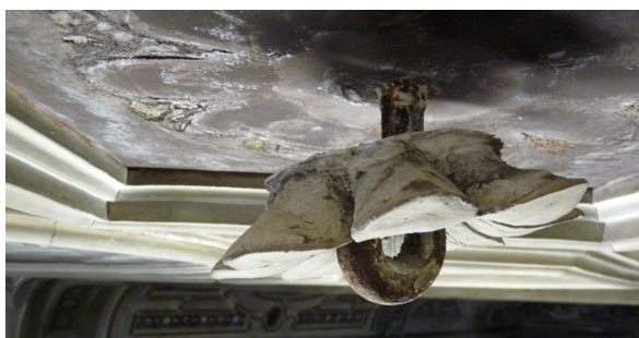
Figure 44 Partie détachée ©CCQ/MCC, Elizabeth Cloutier 2011.
