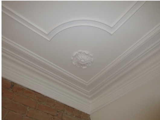
Figure 11 Caissons à coin concave et rosette d'encoignure ©Daniel-Jean Primeau _ COVA-DAAV.
