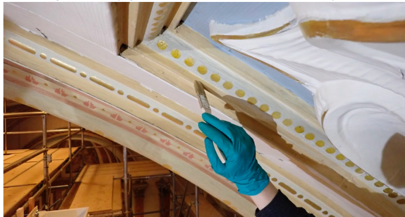
Figure 54 Nettoyage chimique (gel) ©CCQ/MCC, Sylviane Gaume 2021.
