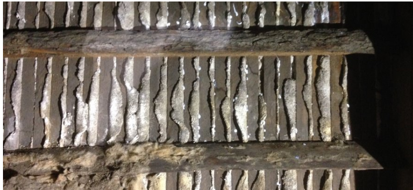
Figure 3 Lattis de bois et clés de plâtre ©CCQ/MCC, Elizabeth Cloutier 2016.
