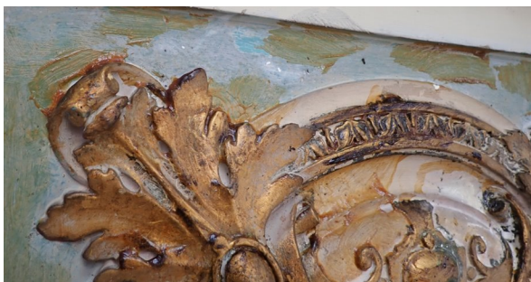
Figure 46 Dépôt superficielle (colle?) ©CCQ/MCC, Camille Beaudoin 2022.
