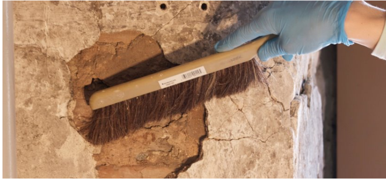
Figure 52 Dépoussiérage de surface ©Elizabeth Clouter 2014.
