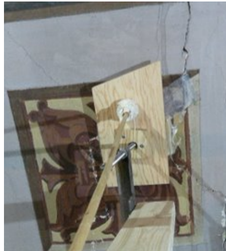
Figure 58 Consolidation des couches d'enduit ©CCQ/MCC, Elizabeth Cloutier 2016.
