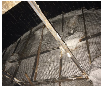
Figure 5 Revers et structure du bas-relief en plâtre de la Bibliothèque Saint-Sulpice (1912-14) ©CCQ/MCC, Elizabeth Cloutier 2016.
