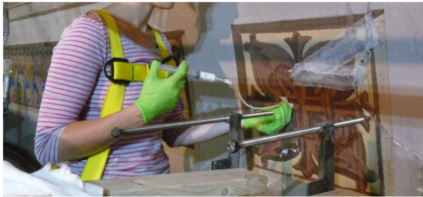
Figure 56 Injection dans les sous-couches d'enduit ©CCQ/MCC, Isabelle Paradis 2016.
