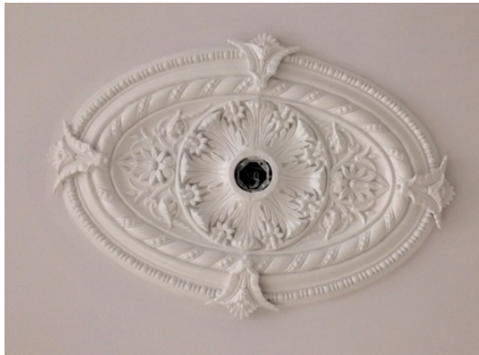
Figure 14 Rosace moulée composée de six pièces ©Daniel-Jean Primeau _ COVA-DAAV.
