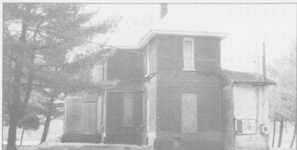
La vieille Maison du lac Henri pourrait être démolie pour faire place à un chalet. (photo: Philippe Pilette)
