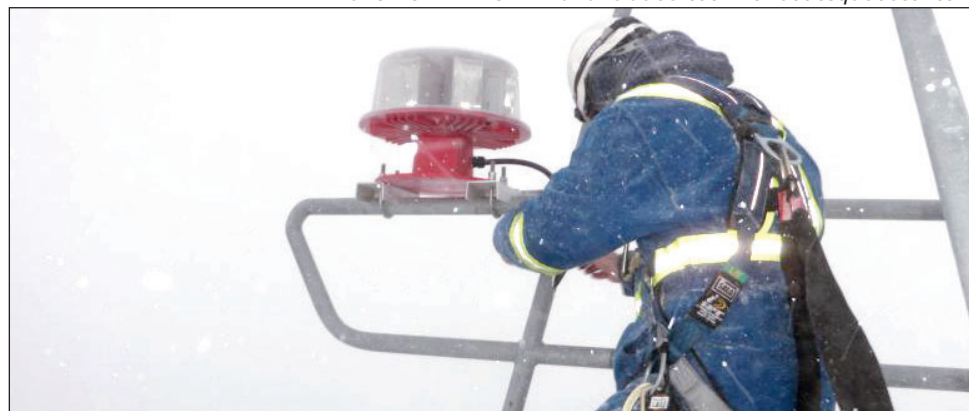
Installation d'une balise lumineuse.
