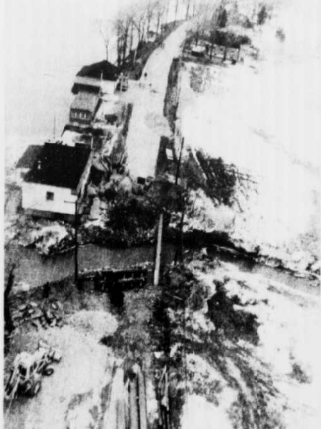
COMME L'AN DERNIER, une section de la route 334, a été littéralement arrachée par l'eau provenant des terres basses pour rejoindre la rivière des Mille-iles. Ici, on voit une équipe qui procède à la construction d'un pont pour enjamber l'obstacle. (PHOTO LA REVUE).
